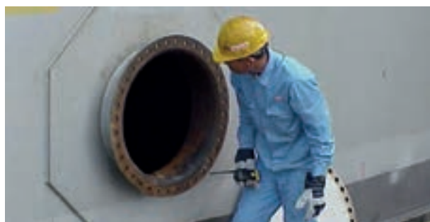
شکل ۴-۲۱- دریچه آدم‌رو مخزن
