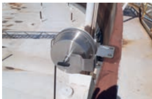
شکل ۴-۲۶- تخلیه الکتریسیته ساکن در مخزن سقف شناور
