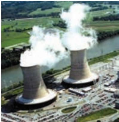
شکل ۳- نمونه‌ای از سامانه‌ی خنک‌کننده گذرا در مجاور رودخانه‌ها
