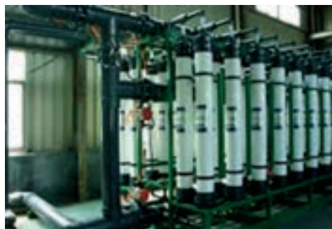
شکل ۱۰- نمایی ساده و واقعی از فرایند اولترافیلتراسیون
