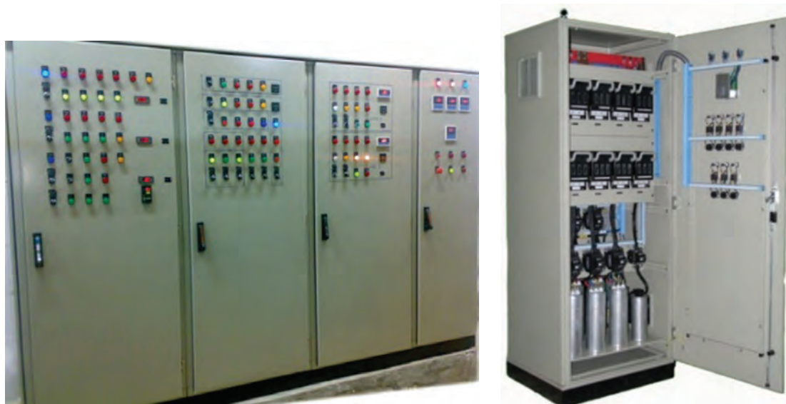
شکل ۱۳- تابلو توزیع برق صنعتی
