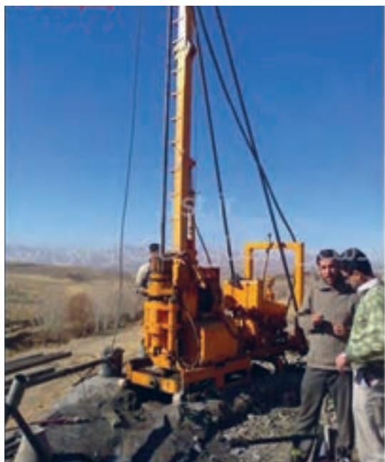
دستگاه حفاری مستقر شده بر روی فونداسیون
