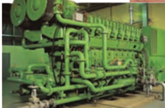
موتور ژنراتور یک نیروگاه برق اضطراری معدن
