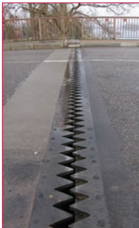
شکل ۲۳-۲ فاصله دندانهای شکل بین دو قسمت پل
