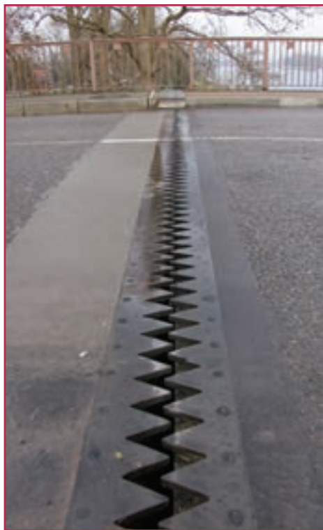
شکل ۲۳-۲. فاصله دندانهای شکل بین دو قسمت پل
