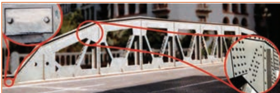
شکل ۳- اتصال دائم : پرچ
