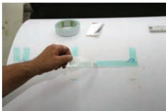
شکل ۲۳- برداشتن روکش چسب
