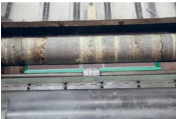
شکل ۵۳- صاف کردن پوشش‌های پرس شده
