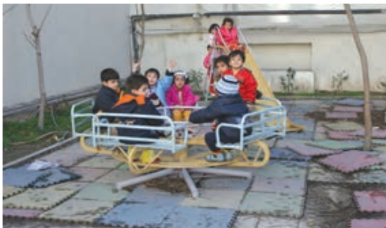
شکل ۲۳- نامناسب بودن کف پوش و محل استقرار سرسره و چرخ‌فلک
