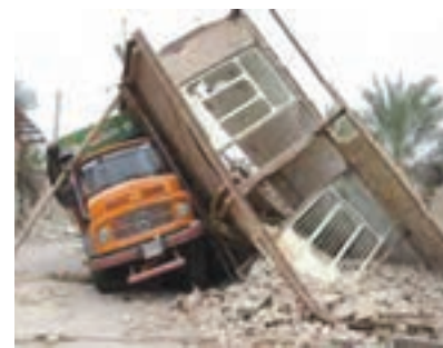
الف) ریزش دیوار در اثر زلزله
