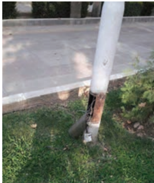
شکل ۲- وجود خرابی در سیستم برق کشی
