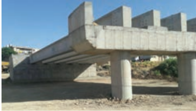
شکل ۱۲- تصویر پل نیمه تمام
