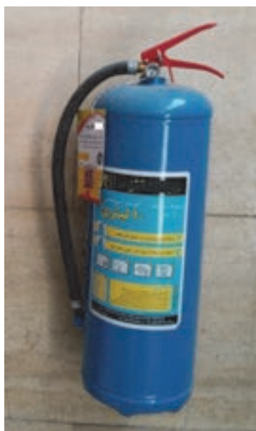
شکل ۱۱- کپسول آتش‌نشانی حاوی مخلوط آب و گاز تصویر شکل ۱۲- کپسول آتش‌نشانی حاوی خاموش‌کننده دی‌اکسید کربن
