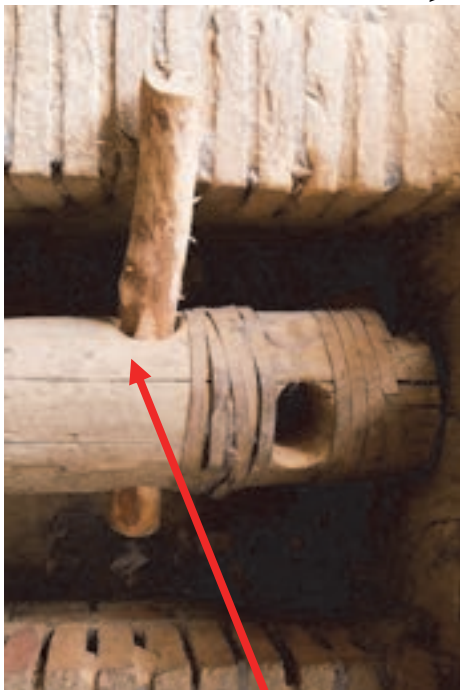
شکل ۳۸- تنگ پایین و نحوه مهار کردن آن بر روی زمین
