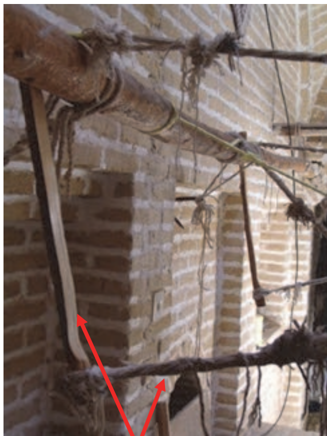
شکل ۳۶- کمونه و نخ اتصال آن
