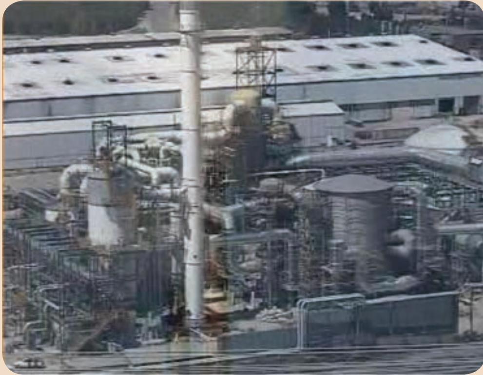
شکل ۶۲-۱- کارخانه اسیدسولفوریک سرچشمه
