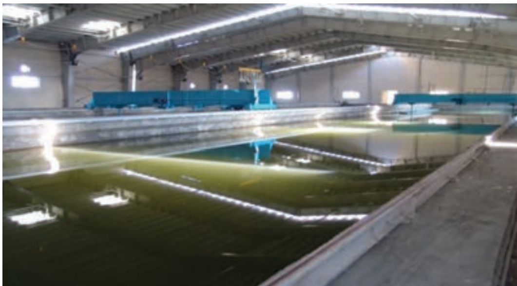
شکل ۴۵-۱- تصفیه خانه آب مشکین شهر
