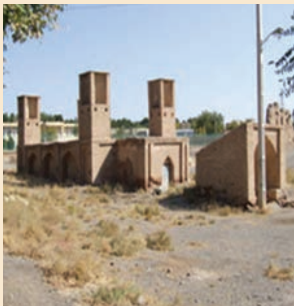
شکل ۳-۴- آب انباری در کوهپایه
