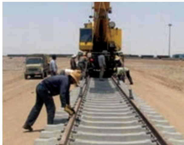
شکل ۱۵-۶- مراحل ساخت راه آهن قزوین - رشت - آستارا
