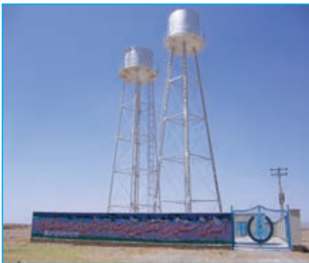
شکل ۱۰-۱۴- اجرای طرح آبرسانی بهداشتی روستایی
