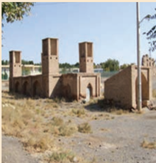
شکل ۳-۴- آب انباری در کوهپایه
