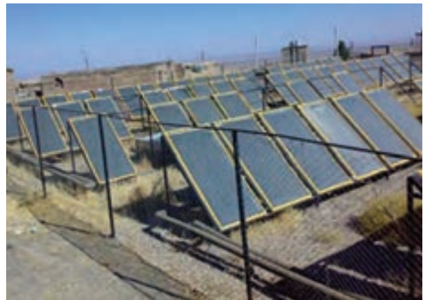
شکل ۵۲-۱- احداث حمام خورشیدی با استفاده از انرژی خورشید -
