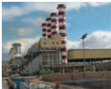
نیروگاه سیکل ترکیبی قم
