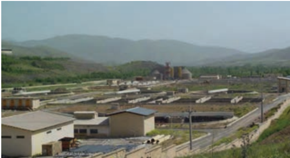
شکل ۷۳-۱- تصفیه‌خانه فاضلاب سنندج
