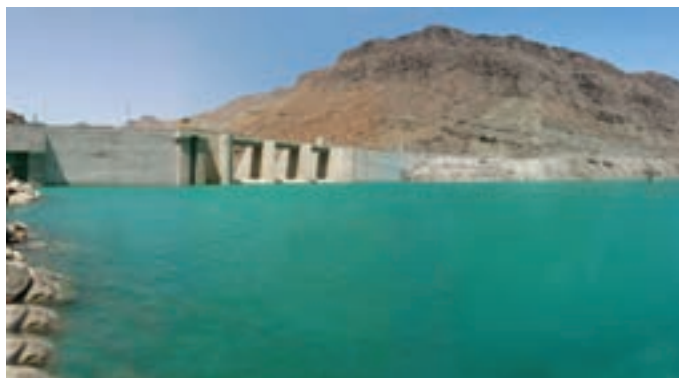
شکل ۲۱-۶- مهار آب های سطحی
