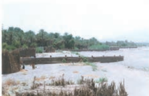
اپی‌های احداث شده با هدف حفاظت کناره‌ها
