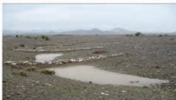
عملیات آبخیزداری احداث بندهای خشکه‌چین شکل ۵۹-۱- مجموعه عملیات آبخیزداری
