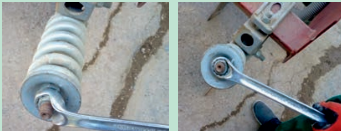
شکل ۴۵- آچارکشی نقاط اتصال اجزا و قطعات
