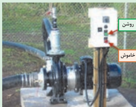
شکل ۲۸-۵. کلیدهای کنترل روی تابلو
