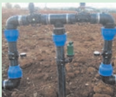
شکل ۳۲-۵. شیر و فشار سنج روی بال ها
