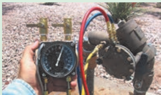
شکل ۳۱-۵. تنظیم فشار شیر فشار شکن
