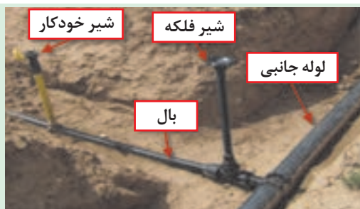
شکل ۱۳-۵. محل شیر فلکه روی بال
