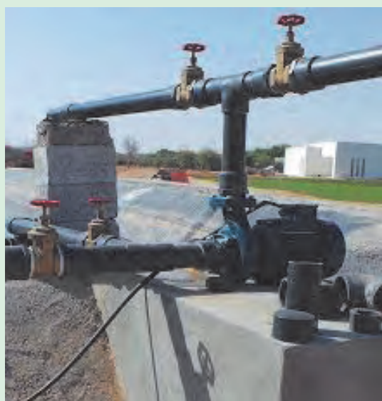
شکل ۱۲-۵. شیر فلکه لوله رانش
