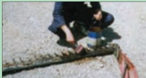
شکل ۵۰- تمیز کردن شانه برش با گازوئیل
