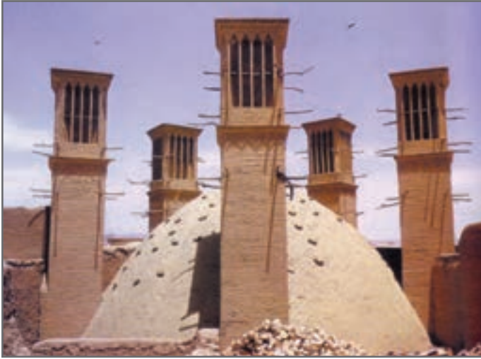
تصویر شماره ۵۰-۲- آب انبار و بادگیرهایش
