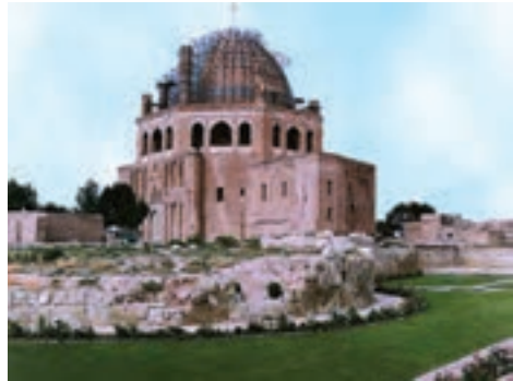
شکل ۳-۶- سلطانیه (بزرگ‌ترین گنبد آجری جهان) با ۲۶ متر قطر و ۵۱ متر ارتفاع از رأس آن تا سطح زمین
