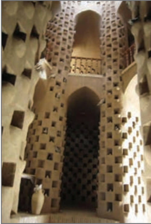
تصویر شماره ۲-۴۷- نمای داخلی برج‌های کبوترخانه
