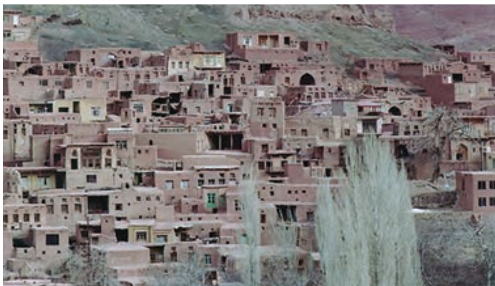
تنوع مصالح و روش‌های اجرا در یک مجموعه‌ی سنتی
