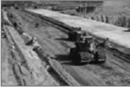
مراحل ساخت سد خاکی
