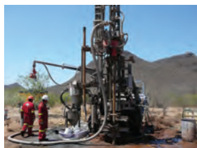
ب) دستگاه حفاری گمانه
