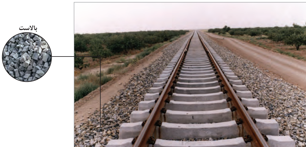
شکل ۴-۱۱- بالاست در زیرسازی جاده ریلی
