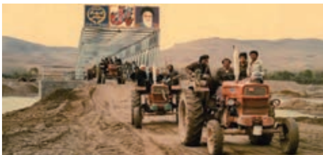
احداث پل وحدت در منطقه کردستان از اقدامات جهاد سازندگی در دوران دفاع مقدس
