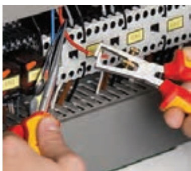
شکل ۹- روکش برداری با سیم لخت کن دستی
