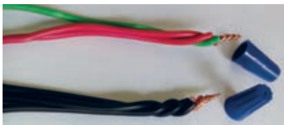
شکل ۴۴- آماده کردن سیم
