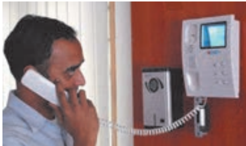
شکل ۱۳- نصب در بازکن
