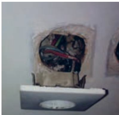
شکل ۳- قاب جداشده پریز از دیوار
