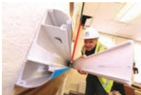
شکل ۴۳- نصب درپوش ترانکینگ
