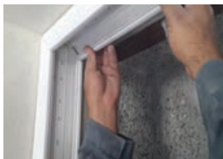
شکل ۵۰- برش و فارسی بر کردن ترانکینگ
