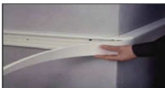
شکل ۴۴- نصب درپوش ترانکینگ زاویه دار
