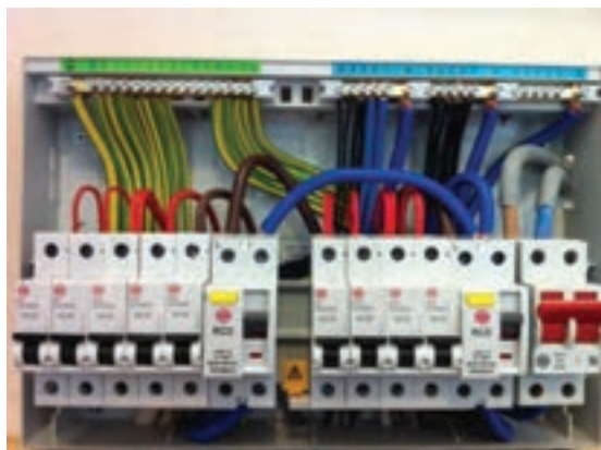
شکل ۴۹- اتمام سیم کشی قطعات تابلو
