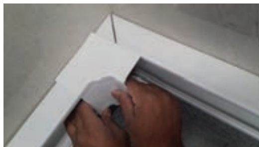
شکل ۵۱- نصب زانوی داخلی
