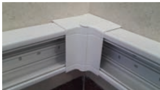
شکل ۵۱- نصب زانوی داخلی
