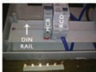
ب) قبل از نصب شین
