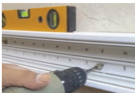
شکل ۴۹- نصب ترانکینگ
