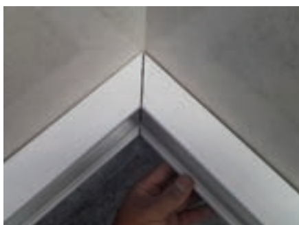
شکل ۵۰- برش و فارسی بر کردن ترانکینگ
