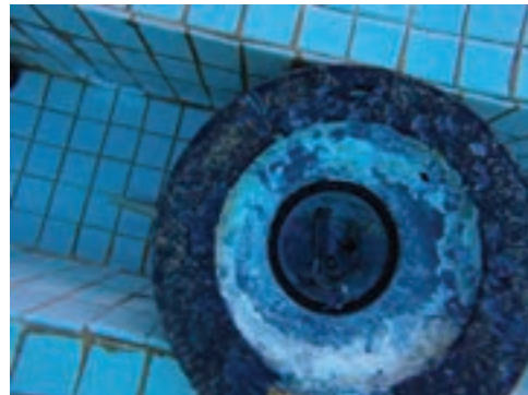
شکل ۴- روشنایی استخر معيوب است و رفع عيب آن بايد با رعايت نکات حفاظتی و ایمنی باشد.
