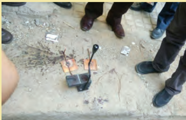
شکل ۹۸- رعایت فاصله از بوته مخصوص جوش اگزوترمیک
