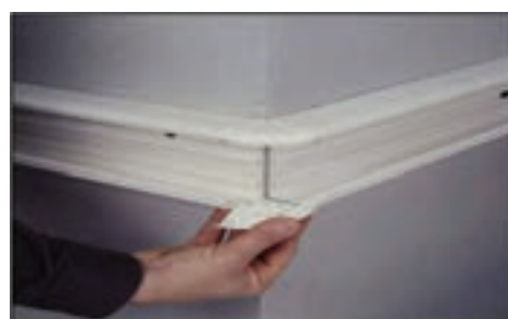
شکل ۴۴- نصب درپوش ترانکینگ زاویه دار
