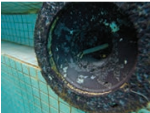
شکل ۴- روشنایی استخر معيوب است و رفع عيب آن بايد با رعايت نکات حفاظتی و ایمنی باشد.
