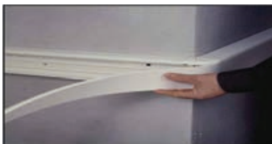
شکل ۴۴- نصب درپوش ترانکینگ زاویه دار
