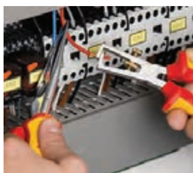
شکل ۹- روکش برداری با سیم لخت کن دستی
