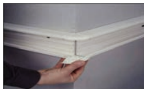
شکل ۴۴- نصب درپوش ترانکینگ زاویه دار
