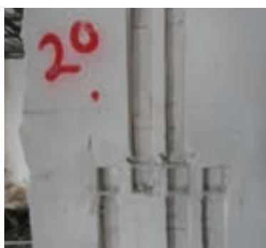
شکل ۳۷- مراحل نصب قوطی کلید و پریز
