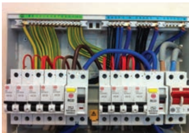
شکل ۹۲- سیم‌کشی نول و اتصال زمین
