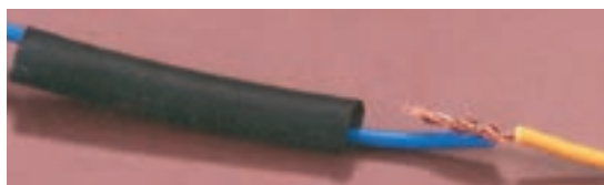
شکل ۲۲- عایق‌کاری اتصال
