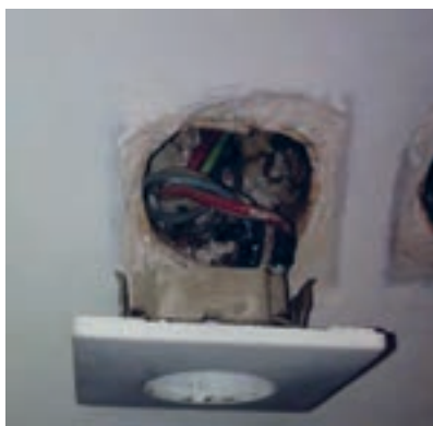
شکل ۳- قاب جداشده پریز از دیوار
