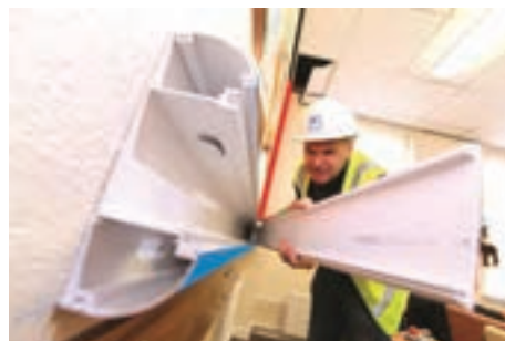
شکل ۴۳- نصب درپوش ترانکینگ
