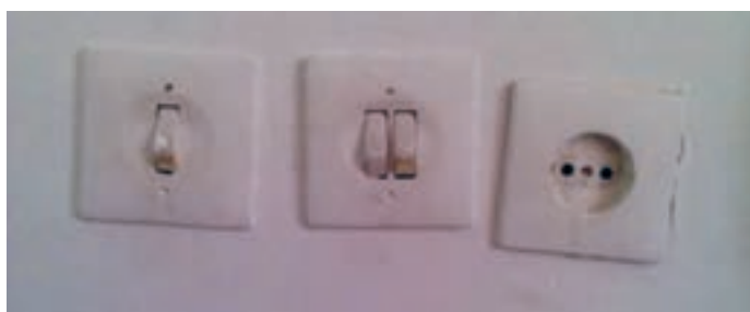
شکل ۱- نصب غلط کلید و پریز
