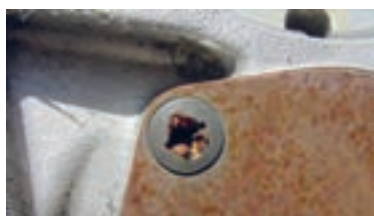
ب) استفاده ناصحیح از آچار پیچ گوشتی
