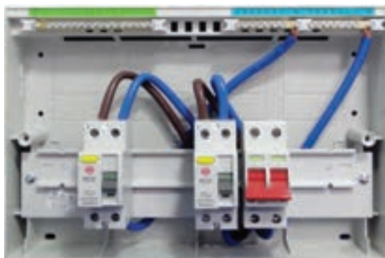
شکل ۴۷- سیم کشی قطعات تابلو
