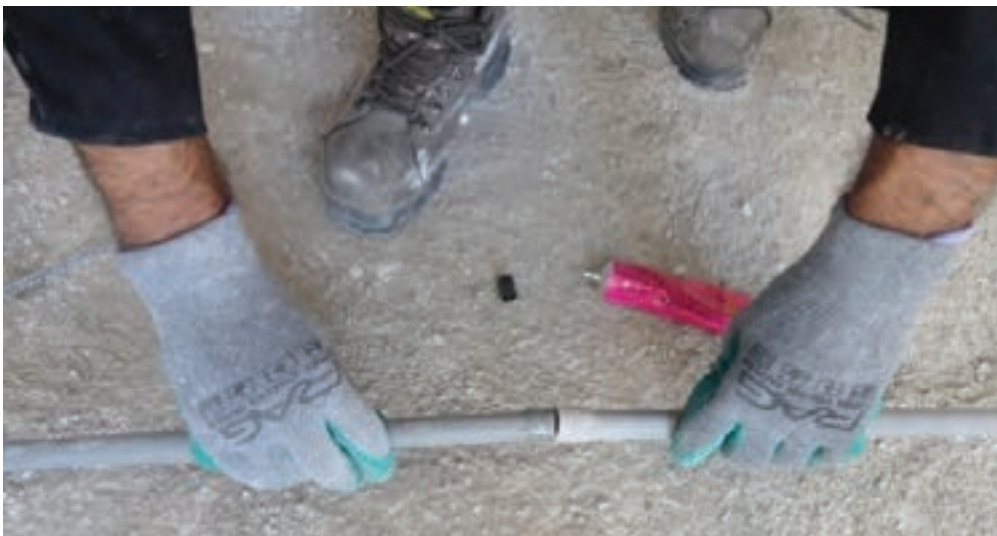
شکل ۴۸- اتصال لوله PVC
