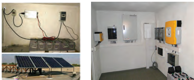
شکل ۴۶- اجرای دو نمونه سیم‌کشی سیستم فتوولتاییک
