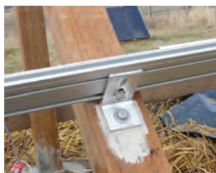
ب) نصب روی پایه آلومینیومی
