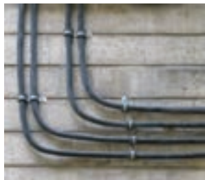
شکل ۲۱- خمش کابل
