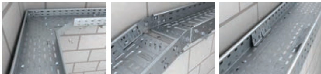
شکل ۴۴- اتصالات سینی کابل
