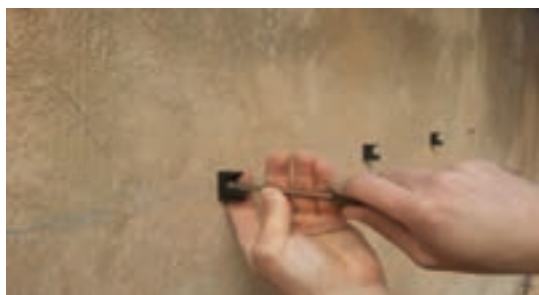
شکل ۳۶- نصب اولیه بست
