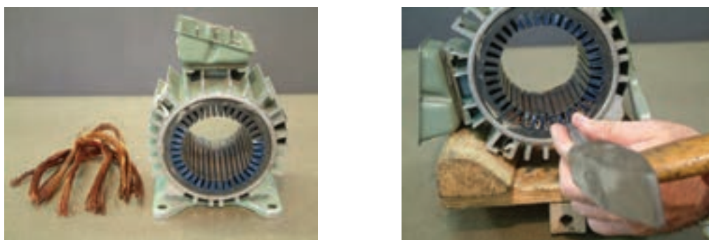
شکل ۲۴-سیم های خارج شده از شیارها
