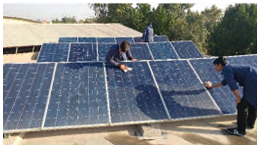
شکل ۴- تمیز کردن مدول‌های خورشیدی
