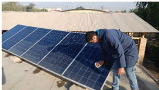
شکل ۵- تمیز کردن با پارچه نرم و آب
