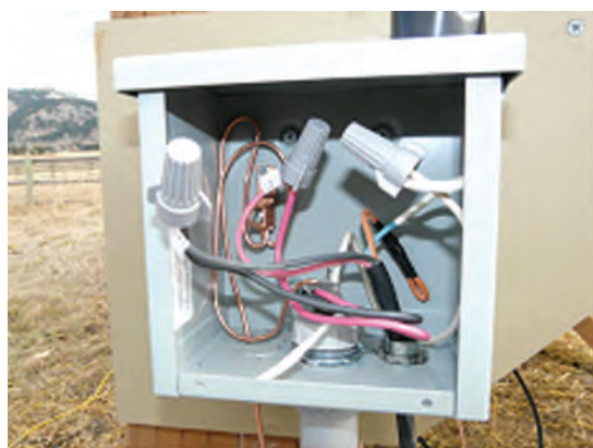
شکل ۳۵- اتصال میله مسی به بدنه تابلو اتصالات
