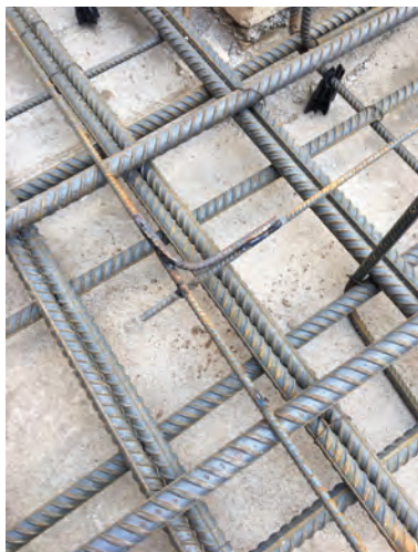
شکل ۲۱- جوش کاری میلگردها در تقاطع سه راهه
