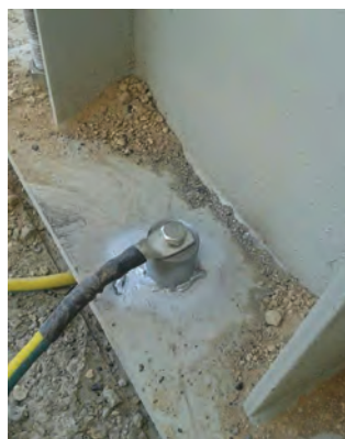
شکل ۲۴- اتصال اسکلت فلزی پیچی
