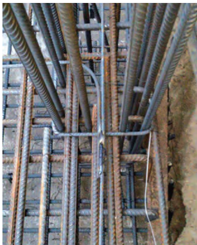
شکل ۲۲- جوشکاری میلگردهای شناژ با شالوده
