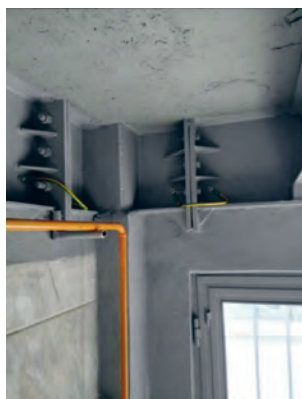
شکل ۲۴- اتصال اسکلت فلزی پیچی
