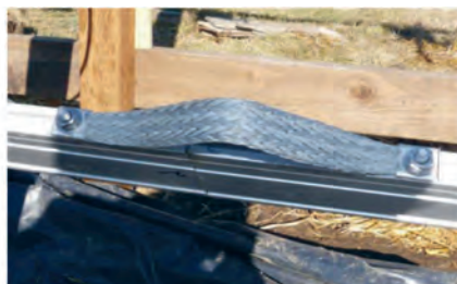
شکل ۲۹- همبندی در سامانه فتوولتاییک
