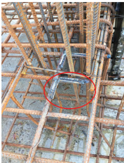
شکل ۱۹- جوشکاری میلگردها در یک تقاطع چهارراه
