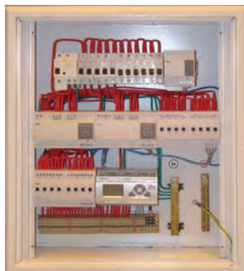
شکل ۵۳- دو نمونه تابلوی توزیع برق (DP)
