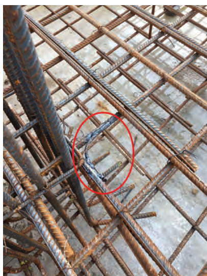
شکل ۲۰- جوشکاری میلگردها در گوشه
