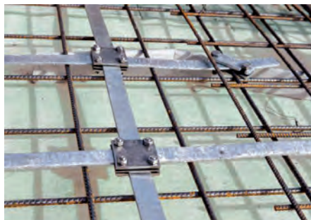
شکل ۹ – تسمه همبندی
