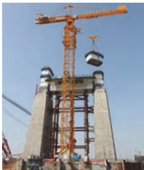
شکل ۲۳- نمایی از جرثقیل برجی (پایه ثابت)
