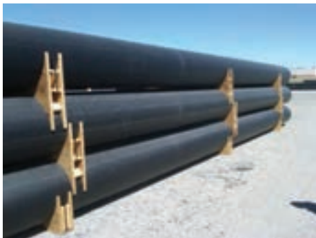
شکل ۱۰-۵- روش‌های مختلف انبار کردن لوله در انبار
