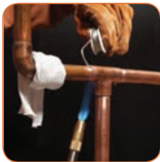
لجیم کاری نقره در لوله مسی
