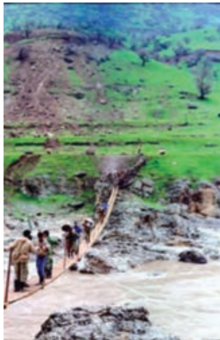
نمونه‌هایی از طرح و اجرای پل نفررو
