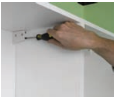
شکل ۲۳ - نصب کابینت با هنگر
