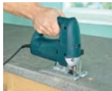
شکل ۱۰۱- برش کاری محل قرارگیری سینک
