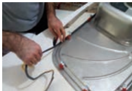
شکل ۱۰۴- نصب نوار آب بندی پشت لبه سینک
