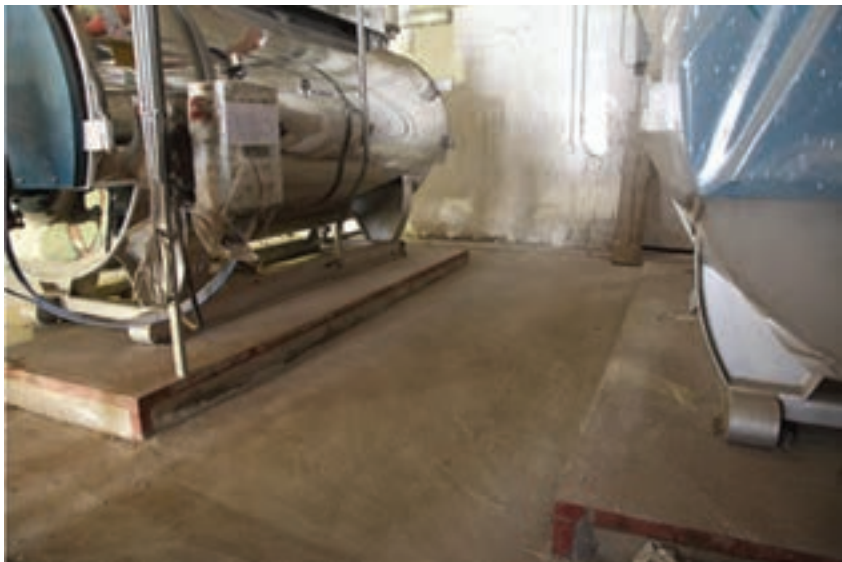
شکل ۱۴ - نصب دیگ روی فونداسیون
